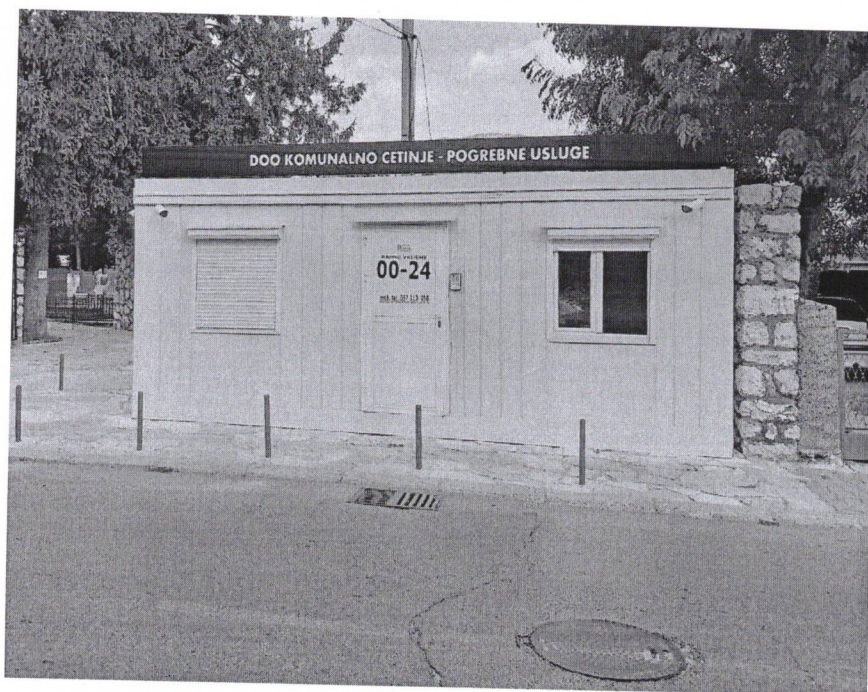
Izgled montažnog objekta
